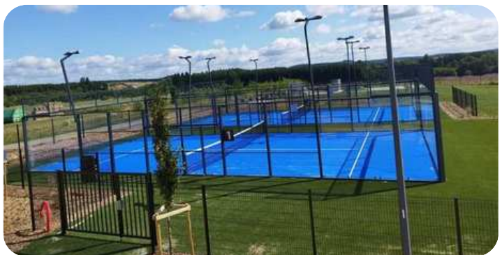
Padel club LEGLISE 2023 - Construction de 2 terrains de Padelés couverts
